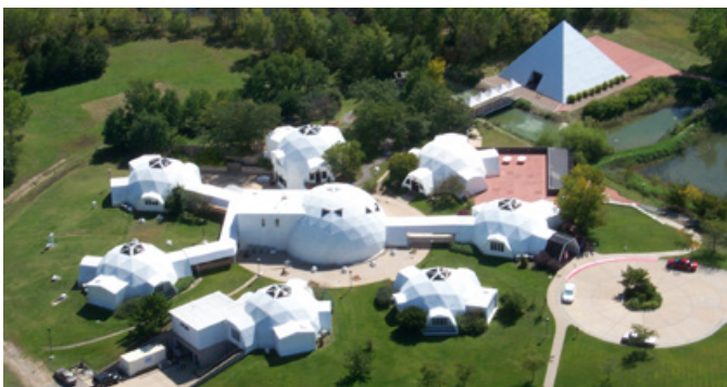
Celkový pohled na Riordan Clinic.
